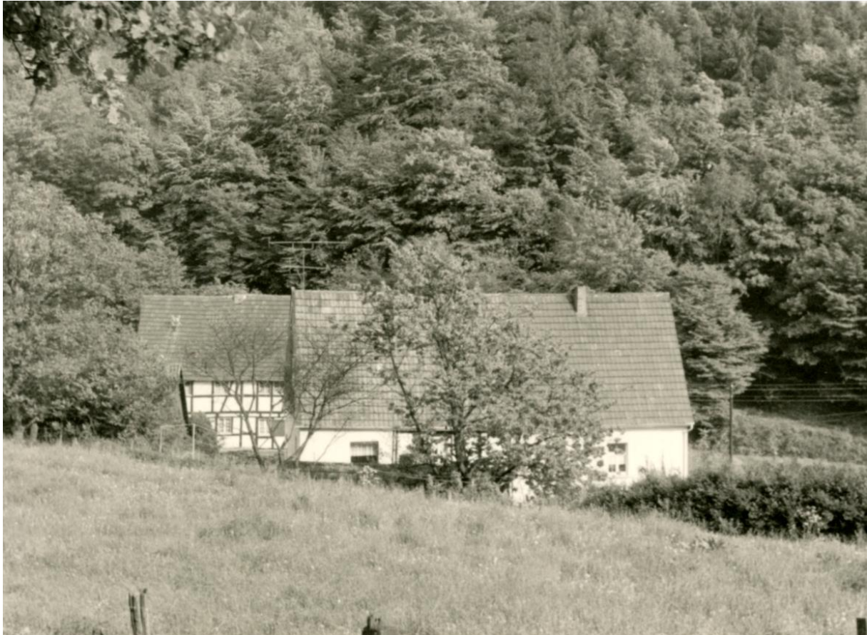
Haus Ley in Honsbach, von Norden, vorn (rechts) der Neubau, hinten (links) der alte leysche Bau. Aufnahme Becker, 1970.
